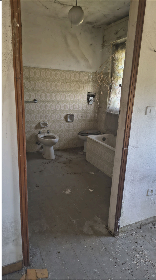
Vista interna bagno posto al piano primo – foto 1
