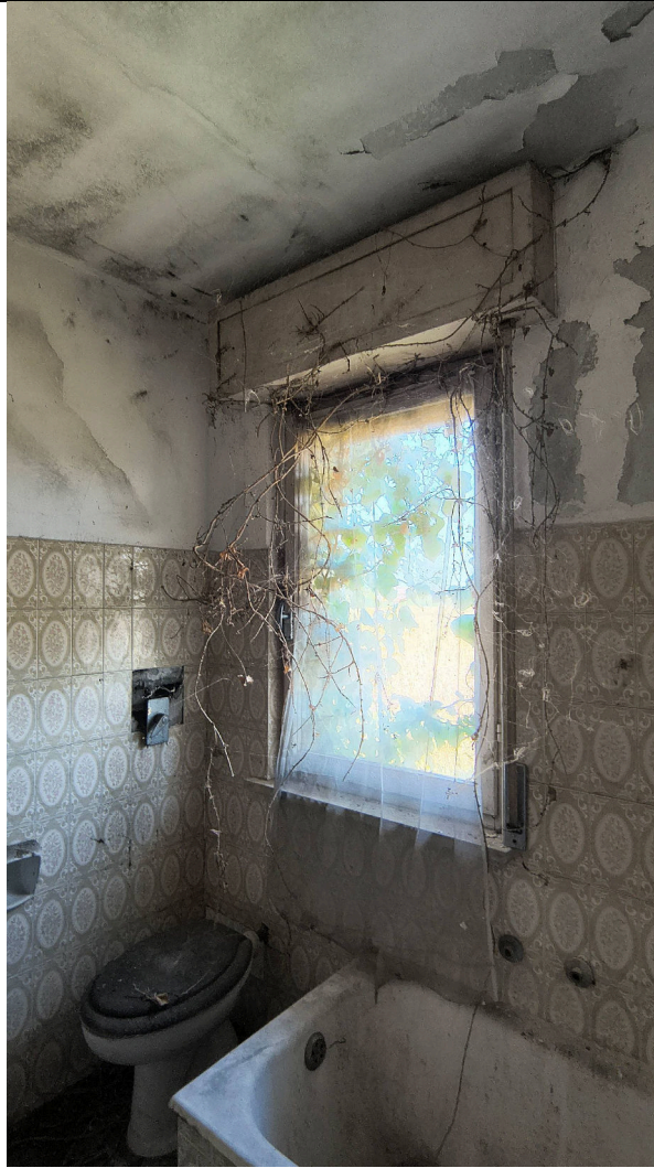
Vista interna bagno posto al piano primo – foto 2
