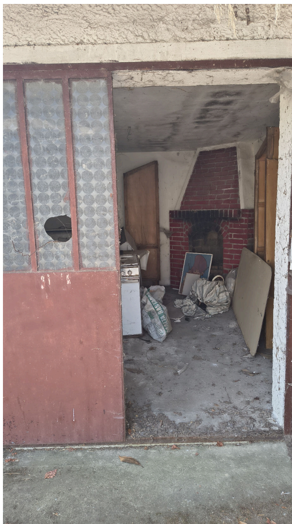
Vista interna lato destro del locale di sgombero – foto 1
