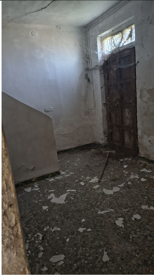
Vista interna piano terra con porta che dà accesso al cortile esterno posteriore
