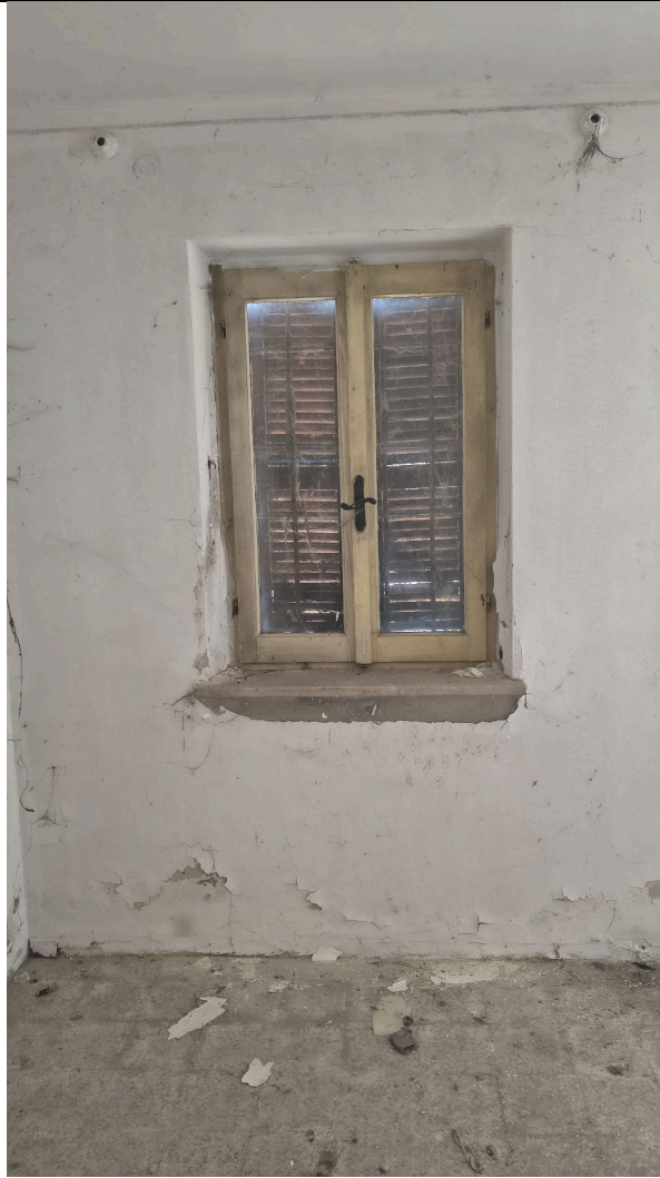
Vista interna finestra presente al piano terra
