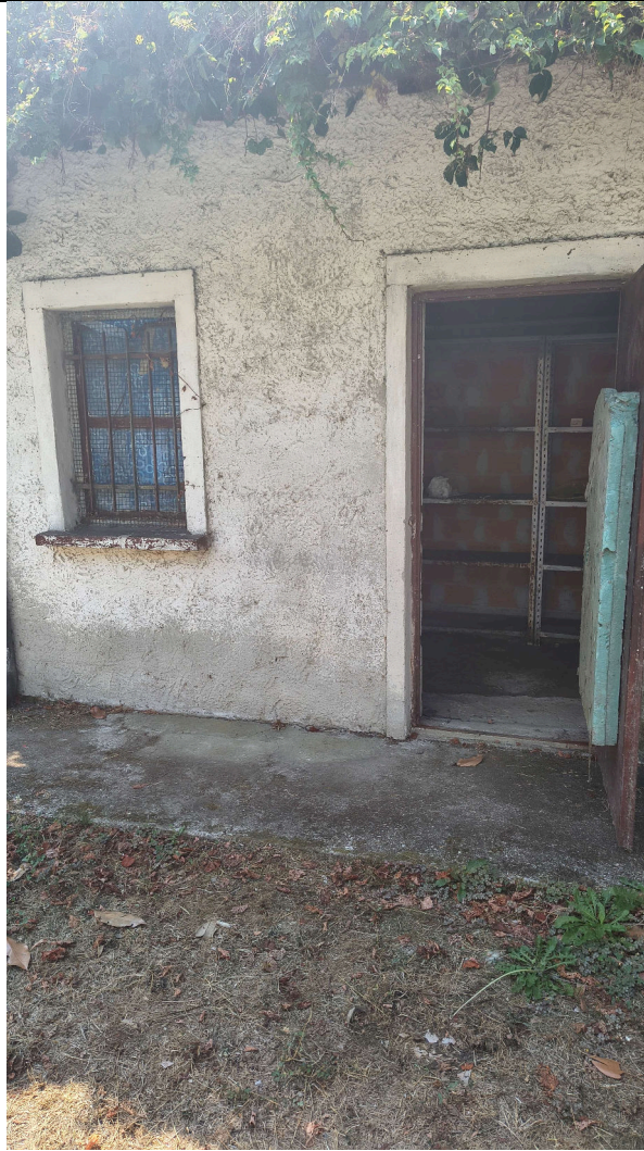
Vista interna lato sinistro del locale di sgombero
