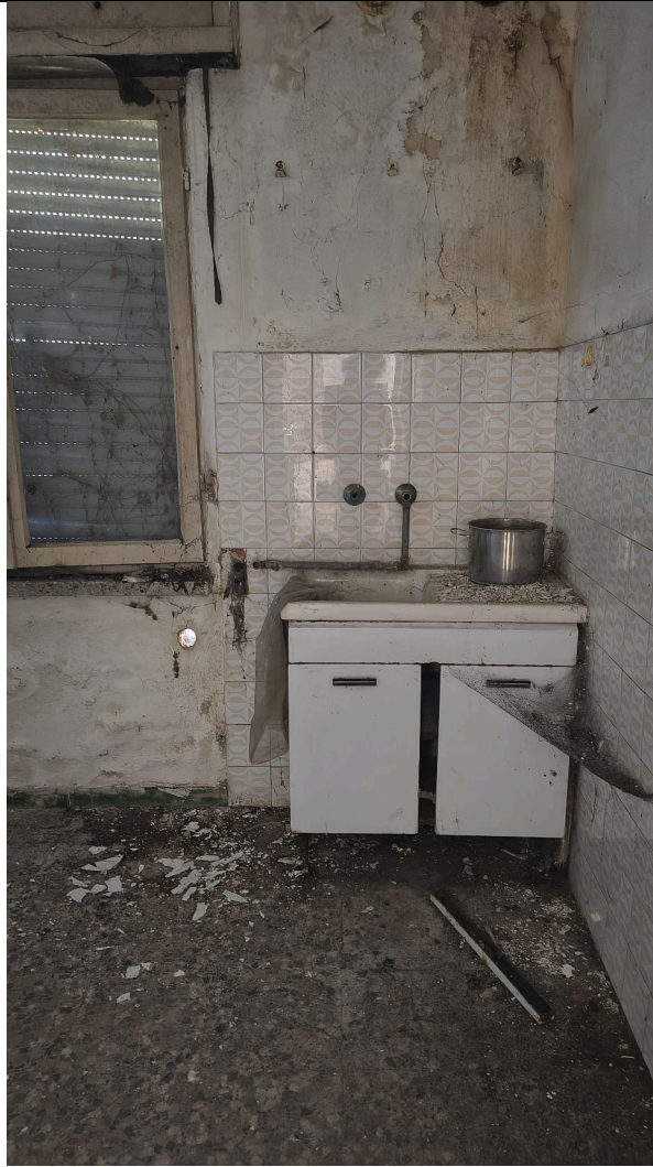
Vista interna porzione posteriore del piano terra
