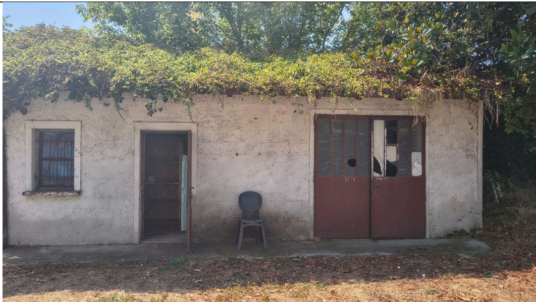
Vista esterna locale di sgombero
