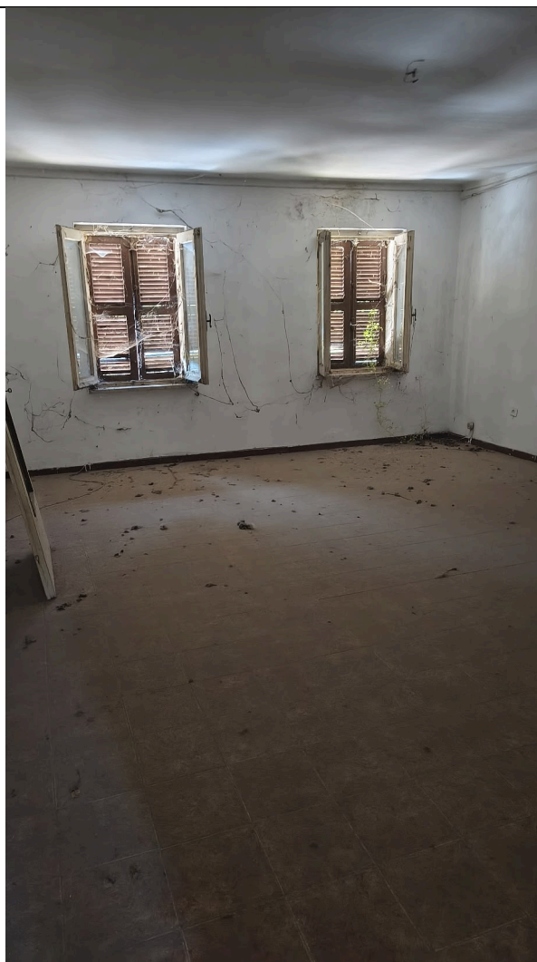
Vista interna camera da letto posta al piano primo
